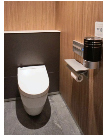
B1F 男性トイレ大便器ブース
