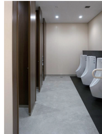
1F東側男性トイレ 小便器コーナー
