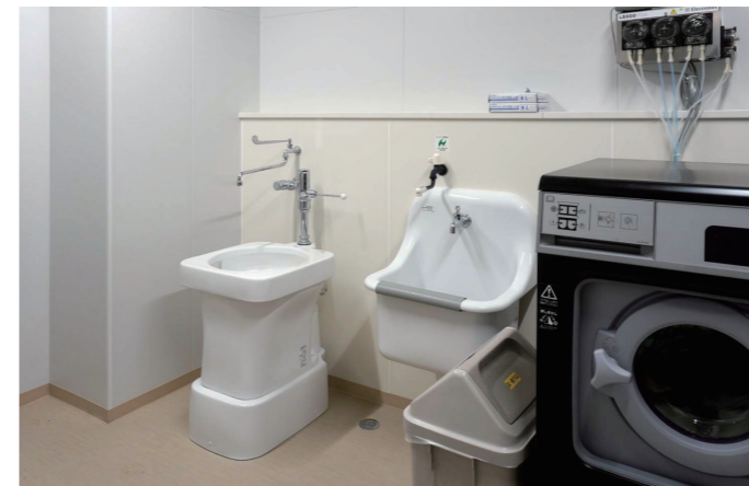
2F 汚物処理室
