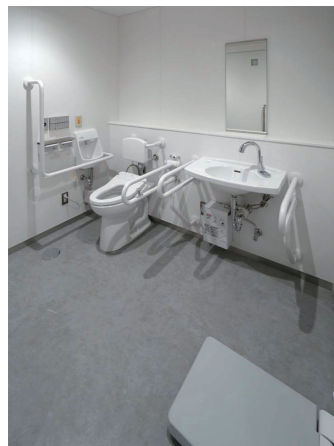
2-4F 広めのトイレ
