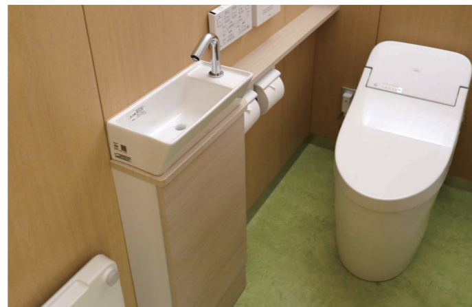
女性トイレ 手洗器設置ブース
