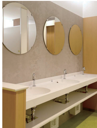
女性トイレ 洗面コーナー
