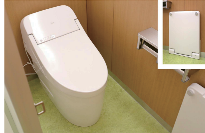
男性トイレ 大便器ブース
