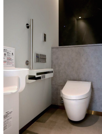
男性トイレ 大便器ブース
