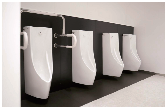
執務フロア 男性トイレ 小便器コーナー
