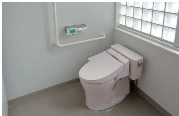
1F女子トイレ 車いす使用者配慮ブース
