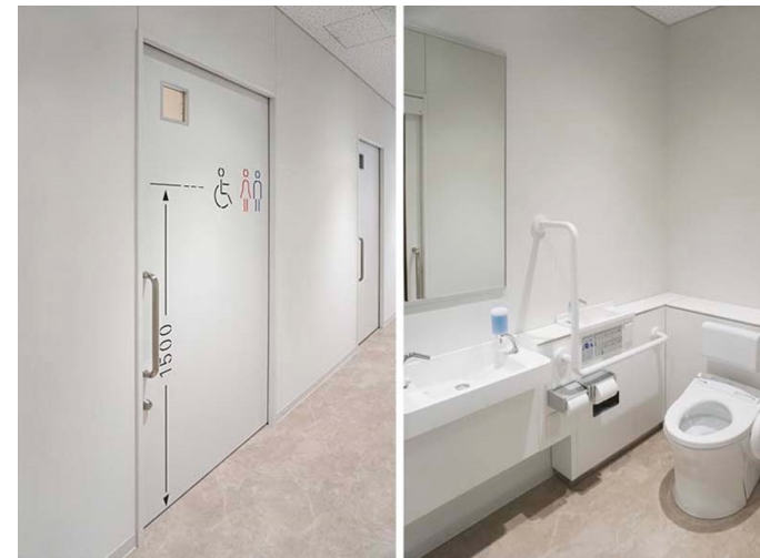
男女トイレの入口の間に多機能トイレ簡易タイプを配置。さまざまな身体状況や性の多様性に配慮して、だれもが日常的に利用できるトイレを用意している。
