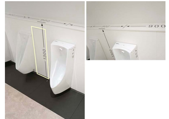
ライニング表面に寸法を表記。小便器のライニング高さ、器具間寸法、必要な点検口サイズを日常的に意識して体感、確認できるようにしている。
