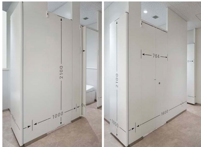
ブース扉は、内開き式と折戸式を選定。折戸式のブースは個室寸法以外に出入りの間口寸法も表記している。
