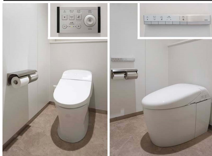
ローシレットのホテル向けウォシュレット一体形便器ホテルリモコンタイプ、ネオレストRHタイプ(スティックリモコンパブリックタイプ)のほか女性トイレ同様に全4種類の大便器を採用している。
