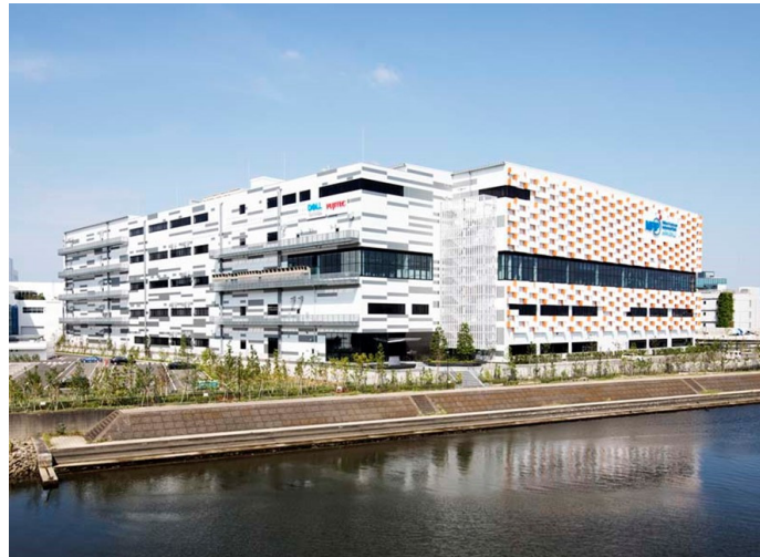
物流倉庫機能を含む複合用途施設の3F、約5,300㎡に梓設計の本社機能を集約している。
