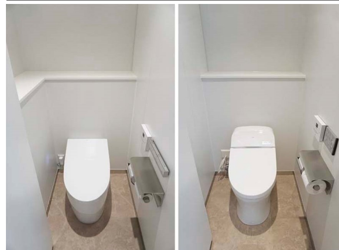
ローシルエットで直線的なデザインのネオレストAH、ホテル向けウォシュレット一体形便器を設置。ライニングはL型とI型の2パターン。複数の荷物を安心して置くことができる。
