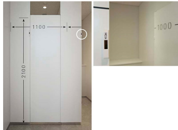
大便器ブースの表面に寸法を記載。設計者が日々の利用で体感しながら寸法を確認することができる。また、センサーを設置し、利用状況のデータ収集を行っている。
