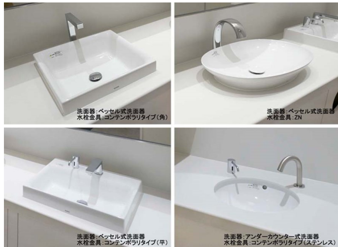
女性トイレと同様の器具を設置。自動水栓はコンテンポラリタイプ角形、平行、ステンレス仕様と、湯水切り替え(センサー式)のZNを選定。
