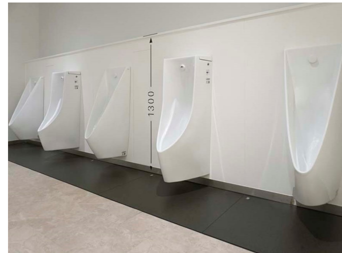
マイクロ波センサー壁掛小便器セットと壁掛自動洗浄小便器を交互に設置。足元には、防汚・防臭機能を備えたハイドロセラ・フロアを設置している。
