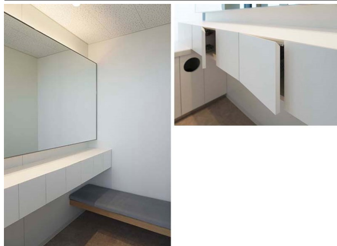
鏡に近づきやすくお化粧直しがしやすいスタイリングコーナー。ベンチがあり、快適に身繕いができるように配慮している。カウンター内に設けた小物入れは、上部に切り欠きを設けた開き扉式。
