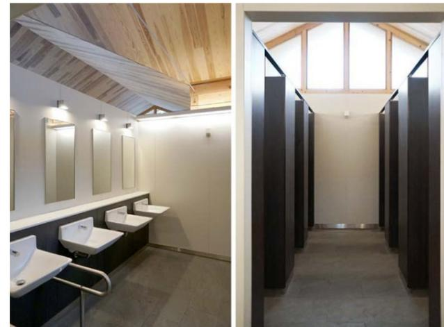
洗面器は、ゆったりとした大きさの壁掛ハイバック洗面器を設置。水栓金具は水じまいがよく、非接触で衛生的な自動水栓が設置されている。大便器ブースは混雑時に配慮した器具数を計画した。
