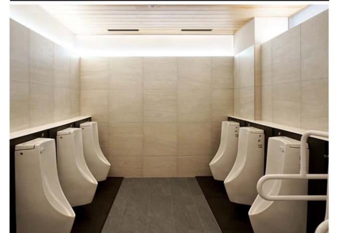
床の清掃性や節水性に優れた壁掛自動洗浄小便器を設置。足元には、防汚・防臭機能を備えたハイドロセラ・フロアを設置している。
