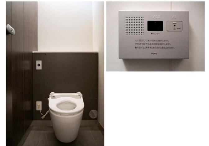
大便器は混雑時に配慮して、連続使用ができる壁掛大便器セット・フラッシュタンク式を選定。女性職員からの提案として音姫(トイレ用擬音装置)を設置している。
