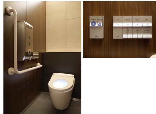
大便器は混雑時を考慮して連続使用ができる壁掛大便器セット・フラッシュタンク式を選定。さらに、ボタンを押すたびに発電し、電源工事や乾電池の交換が不要なエコリモコンを設置している。
