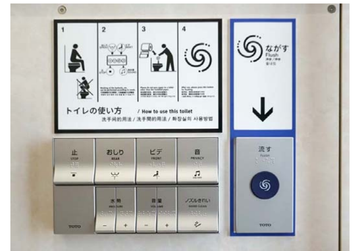
ウォシュレットのリモコンは、ボタンを押すたびに発電する電源工事が不要なエコリモコンを採用。外国人にもわかりやすいように、リモコンの上にイラストとピクトグラム、多言語で使用方法を掲示している。
