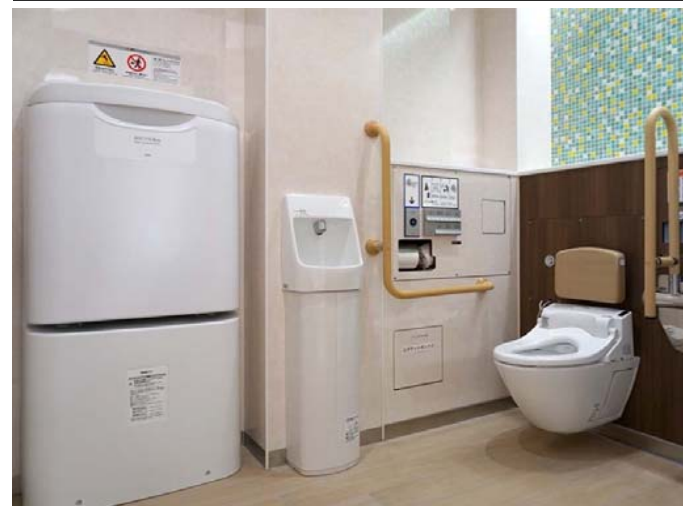
車いす使用者やベビーカー使用者に配慮した大型ブース。コンパクト手洗器を設置し、ブース内で手洗いができるようになっている。
