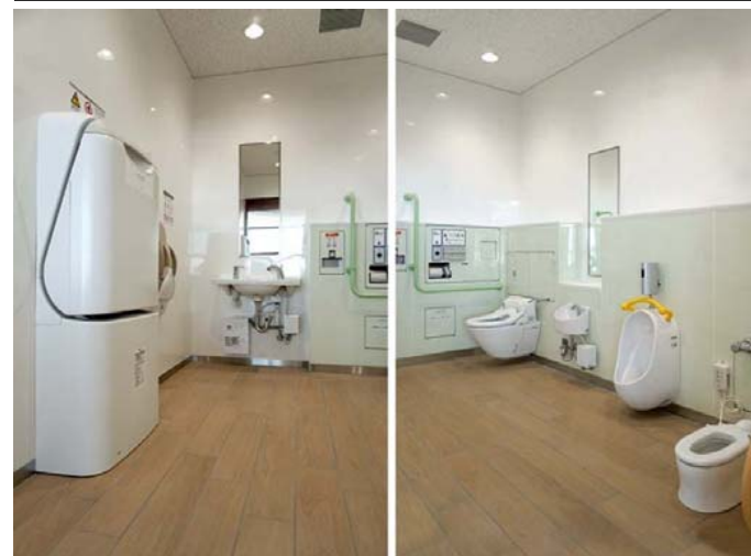
小さなお子さま連れに配慮したキッズトイレを隣接させて2室配置。幼児用器具を充実させると共に、保護者も一緒に利用できるよう、大人用大便器を設置している。
