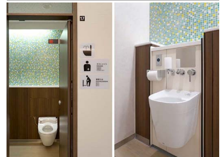
コンパクトオストメイトパックを設置したオストメイト対応ブースを多機能トイレや大型ブースとは別に設けることで、トイレ機能の分散を図っている。
