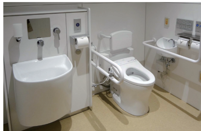
2F共用部 多機能トイレ
