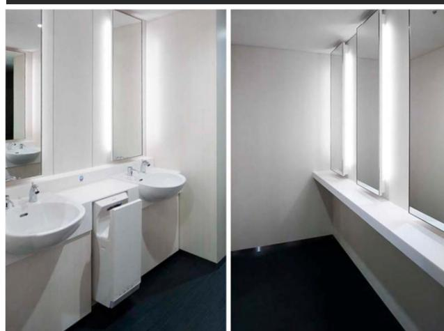
床への水はねを抑える配慮として洗面器の間に、温風乾燥機を併設。また、混雑緩和のため、洗面コーナーとは別にスタイリングコーナーを設置。顔映りに配慮した照明付化粧鏡を採用している。
