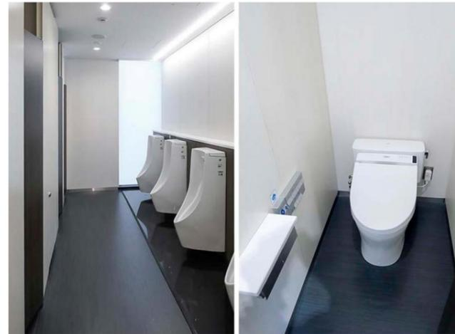
床の清掃性や節水性に優れた壁掛式自動洗浄小便器を採用。すべての大便器にウォシュレットを設置。リモコンは、ボタンを押すたびに発電し、乾電池交換や電源工事が不要なエコリモコンを採用している。
