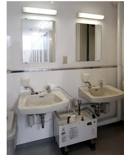
男性トイレとともに洗面コーナーは未改修。以前よりお湯の出るアクアオート(自動水栓)が使用されている。
