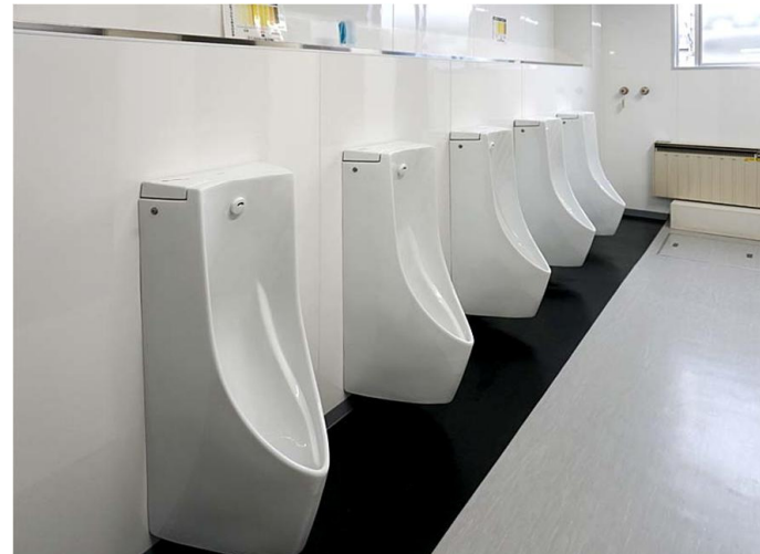
改修前はタイル張りだったおだれ石を、においや汚れを軽減するハイドロテクト・フロアにし、小便器前の壁は汚れを拭き取りやすいキッチンパネルで仕上げている。
