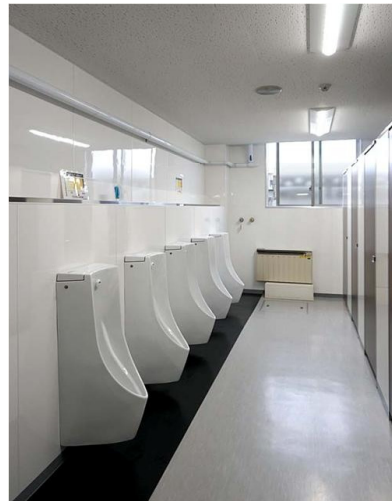
壁、床を白い部材に張替えたことと、照明をLEDに変更して照度を上げたことで、空間全体が明るい雰囲気になっている。
