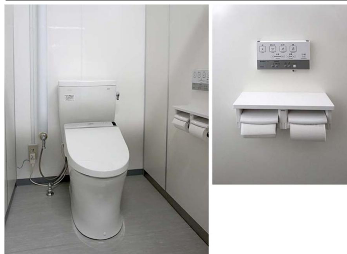
和洋リモデル工法を用い和式便器から洋式便器に変更し、すべての大便器にウォシュレットを完備。ブース内の寸法はW1000×D1300mmと空間を広めに確保している。
