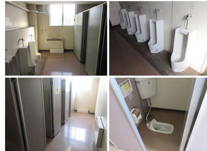
改修前は、印象が暗いトイレ空間。洋式便器が男性トイレ女性トイレそれぞれ1つのみであったため、不便を感じていた。
