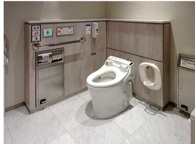
2. 5F女性トイレ 大便器ブース内
