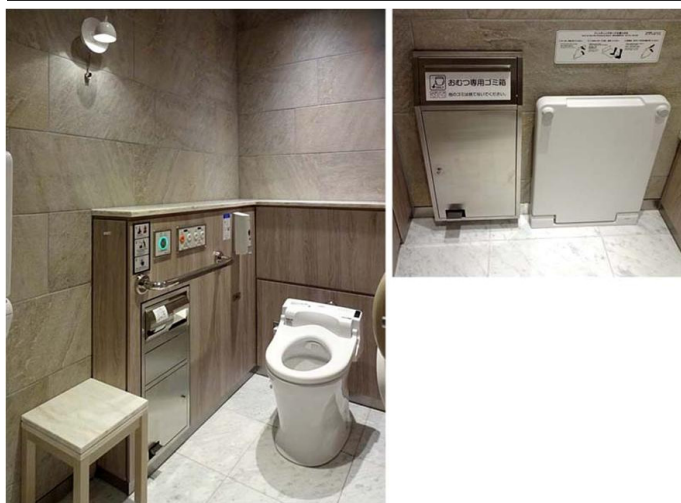
広めのブースには、お子様連れ配慮としてベビーシート、ベビーチェア、フィッティングボード、幼児用補助便座を設置。全ブースライニングとは別に可動式の荷物置台も置いてある。
