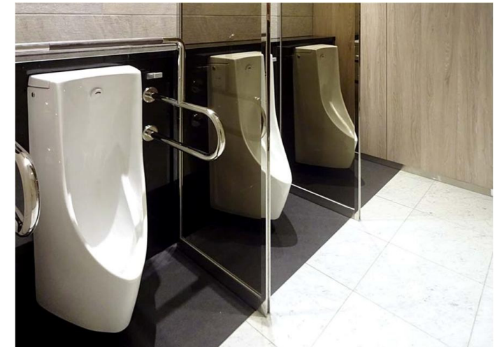
全フロアプライバシーに配慮し間仕切りを設置。間仕切りは、ガラスに高級感のあるシート貼りとし、空間を広々と見せるため、シートには、あえて透け感のある色を選定した。
