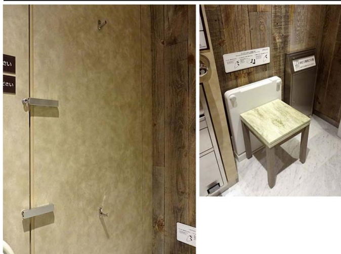
ドアには、高さを変えてカギを2ヶ所設置。上部のカギを開けておけば、お子様がドアを開けることもなく安心して使用できる。お子様連れ配慮としてベビーシート、フィッティングボード、おむつ専用ごみ箱を設置。
