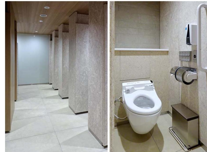
すべての大便器ブースに手すりを設置。大便器ブースを天井まで立ち上げて個室感を高めている。
