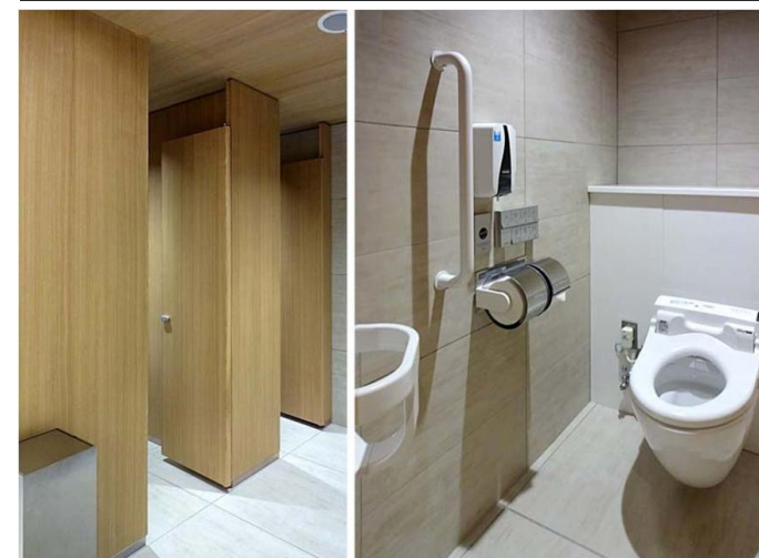
「表示がわかりやすく、押しやすい」「環境にも配慮できメンテナンスも楽になる」という理由から、ウォッシュレットはエコリモコンを採用。
