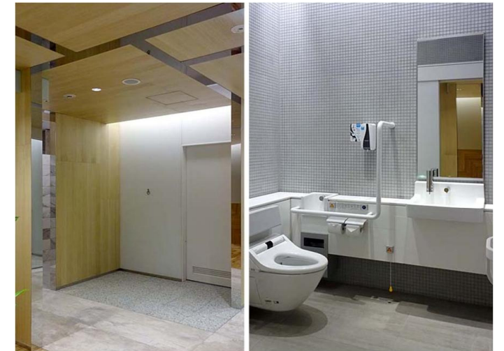
M2F同様、4Fフロアにも、RESTROOM ITEM01の多機能トイレパックを設置。入口スイッチはドアの動作状況に応じて、音声でガイドしてくれる。
