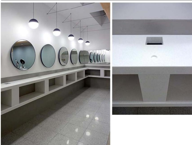
荷物棚やダストボックスが設置された使い勝手のよい設計のパウダーコーナー。カウンターの縁近くを丸くくり抜き、長傘の柄をかけられるような、センスと利便性を両立させるディテールにもこだわった。
