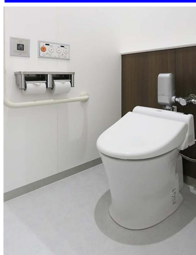
環境や衛生面に配慮して、節水タイプでセンサー式のパブリックコンパクト大便器を採用。すべての大便器にウォシュレットを設置している。
