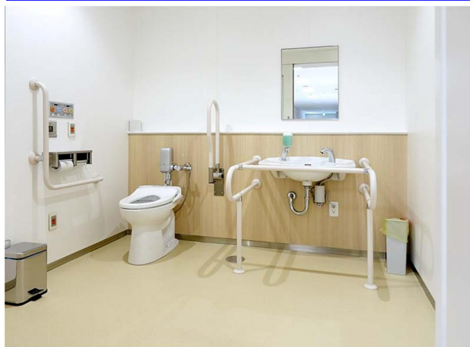
車いすから移乗しやすいように便器の両側に、L型手すりとはね上げ手すりを設置している。大便器にはウォシュレットを設置。
