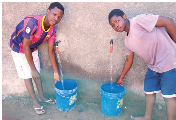
プロジェクトで設置した給水設備
