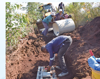
パイプ網施設・給水システム工事
