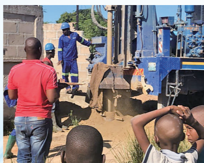
掘削機を使用したボーリング
