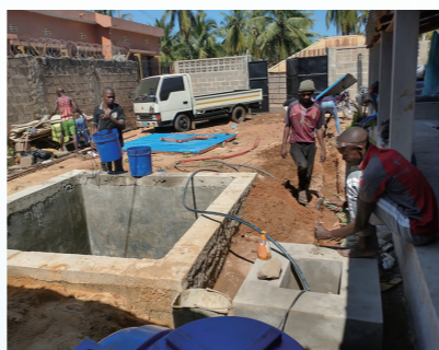
井戸設置工事
