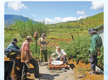
マザーズスペース設置作業
