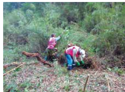
伐採木の処理
