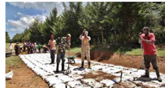
土のうによる道直し作業(ケニア)
