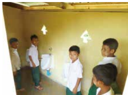
学校敷地内に建設したトイレ
