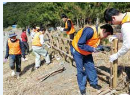
防風防砂のための竹垣の設置・修復作業
