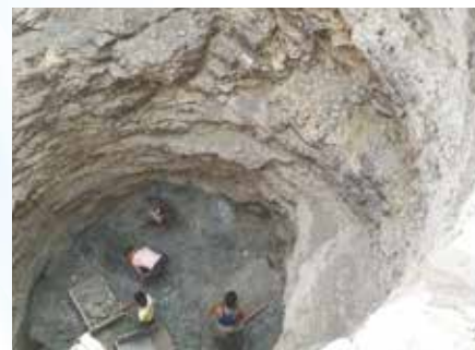
古井戸の再生(ダイナマイト破壊後の人力作業)
