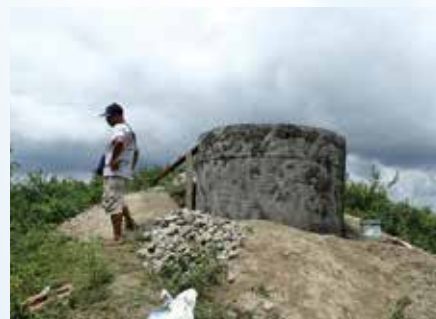
小高い地点にタンクを設置
