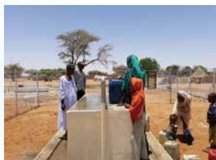
完成した給水所で水を汲んでいる住民
