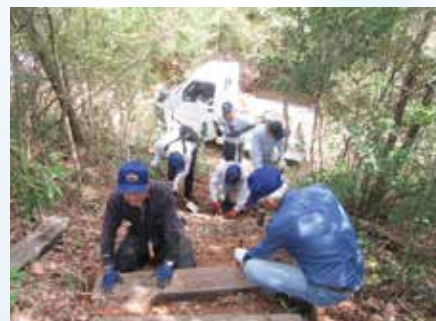
美佐野街道の途中にある古墳入口の階段を補修整備
