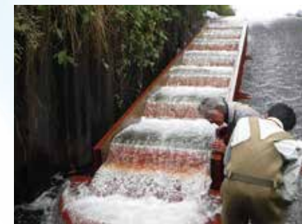
鉄骨改良型魚道の設置
