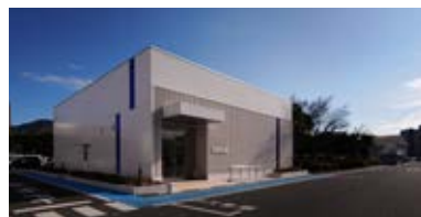
水素発生装置設置の建屋 (Sui Station)
