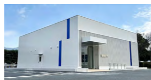
水素発生装置設置の建屋 (外観)
