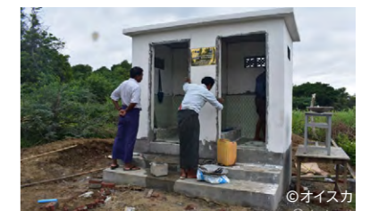
ミャンマーでのトイレ建設 (オイスカ)
