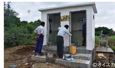
ミャンマーでのトイレ建設(オイスカ)
