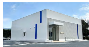
水素発生装置設置の建屋 (外観)
