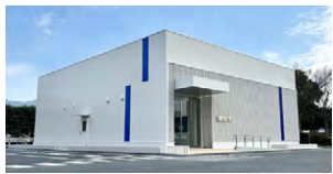
水素発生装置設置の建屋（外観）
