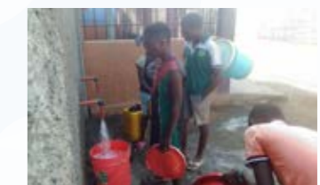
モザンビークでの配水管の設置 (モザンビークのいのちをつなぐ会)
