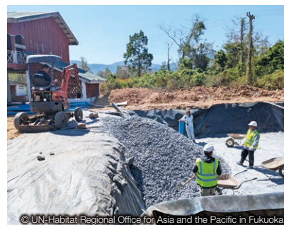
Pouring crushed stones
