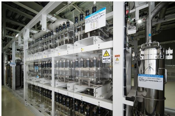
再生可能エネルギー電力を利用し、水を電気分解することで、CO<sub>2</sub>を排出しない「グリーン水素」を製造する水素発生装置を2025年4月に稼働開始。今回のグリーン水素の製造により、北九州市から「低炭素水素認証」第一号に認定されました。
