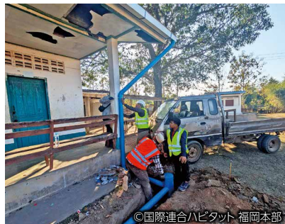
地中配管の設置
