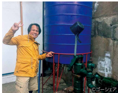
ラーニングセンターに設置した貯水タンク
