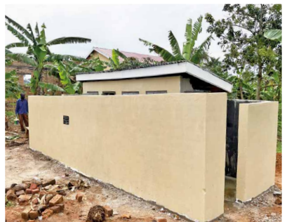
完成したトイレ
