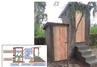
完成したエコサントイレとその仕組み
